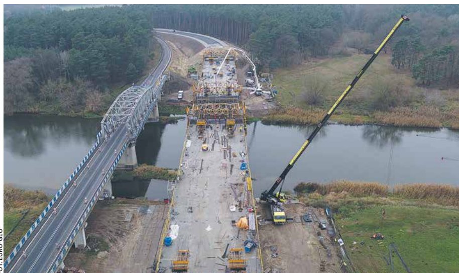
Nowa, szersza przeprawa w Rogalinie zastąpi stary obiekt.
