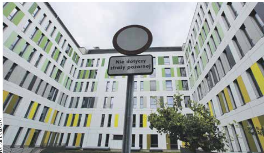
W przyszłym roku zostanie m.in. zakończona budowa Wielkopolskiego Centrum Zdrowia Dziecka.
