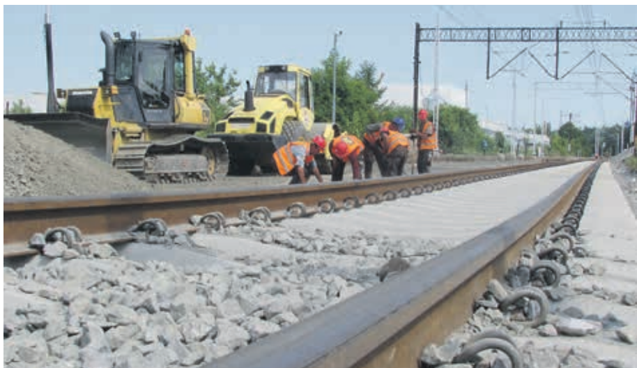
Każdy ukończony remont torów sprawia, że pociągi mogą kursować szybciej.
