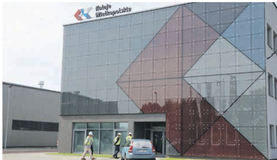
W Wągrowcu trwają prace przy nowoczesnym punkcie utrzymania taboru.
