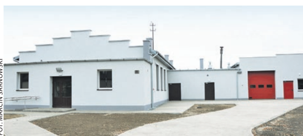
Sala OSP w Trzebieniu po rozbudowie dofinansowanej z PROW 2014-2020.
