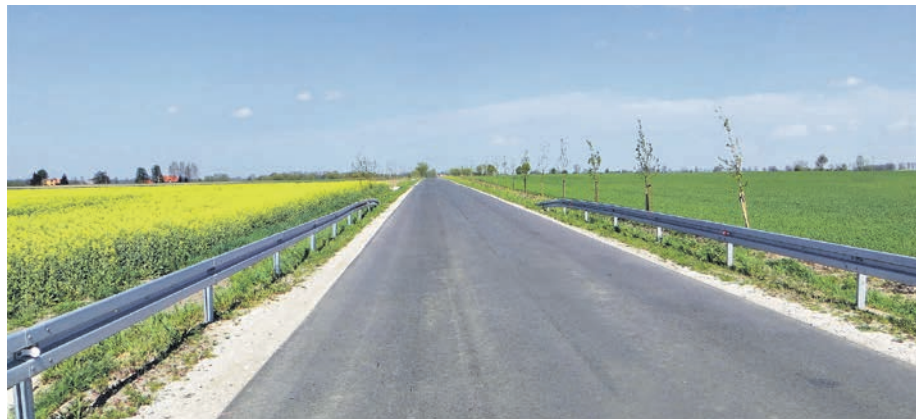
Przebudowana droga na odcinku Łekno – Rąbczyn w powiecie wągrowieckim.
