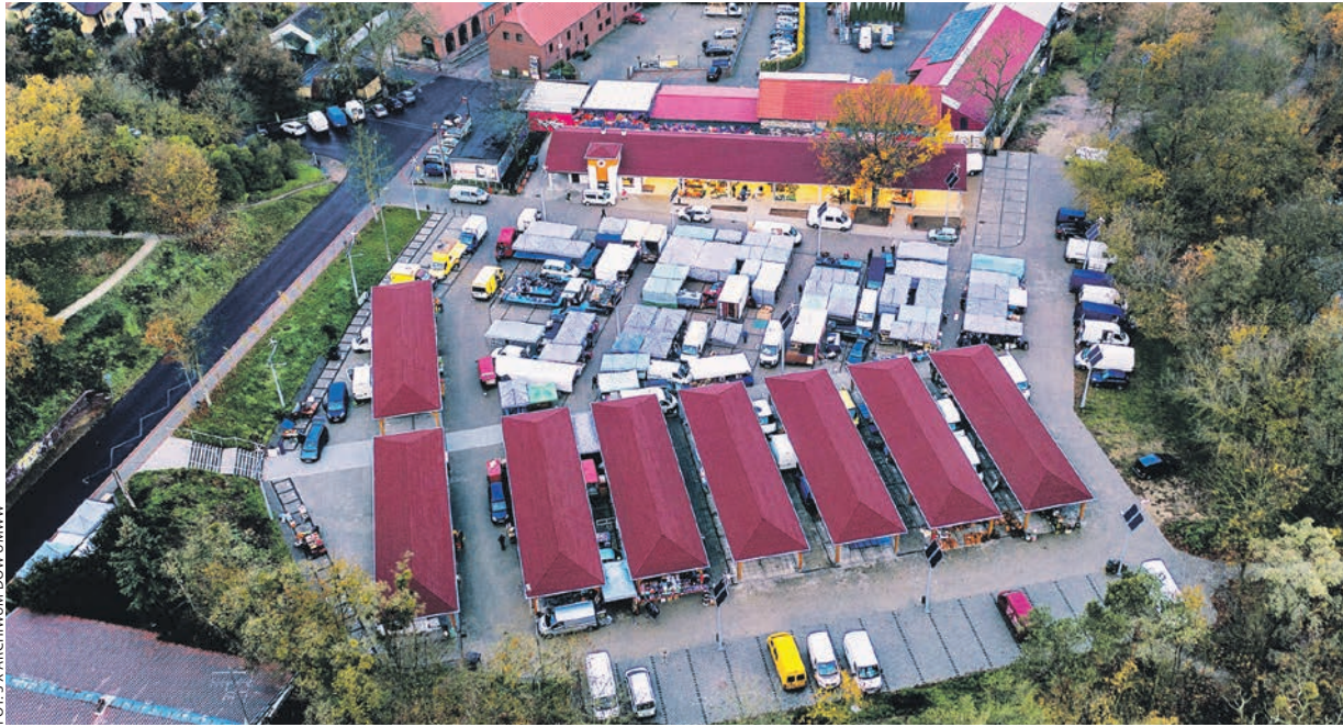
Niemal 1 mln zł z PROW wsparło modernizację targowiska miejskiego w Obornikach.
