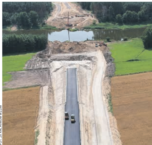
Trwają prace przygotowujące budowę przeprawy przez Wartę.
