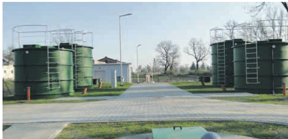
Oczyszczalnia ścieków w Sepnie w gminie Kamieniec zbudowana dzięki dofinansowaniu z PROW 2014-2020.
