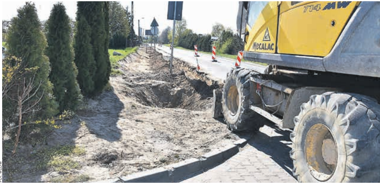
Prace trwają m.in. w ramach przebudowy drogi wojewódzkiej nr 306.
