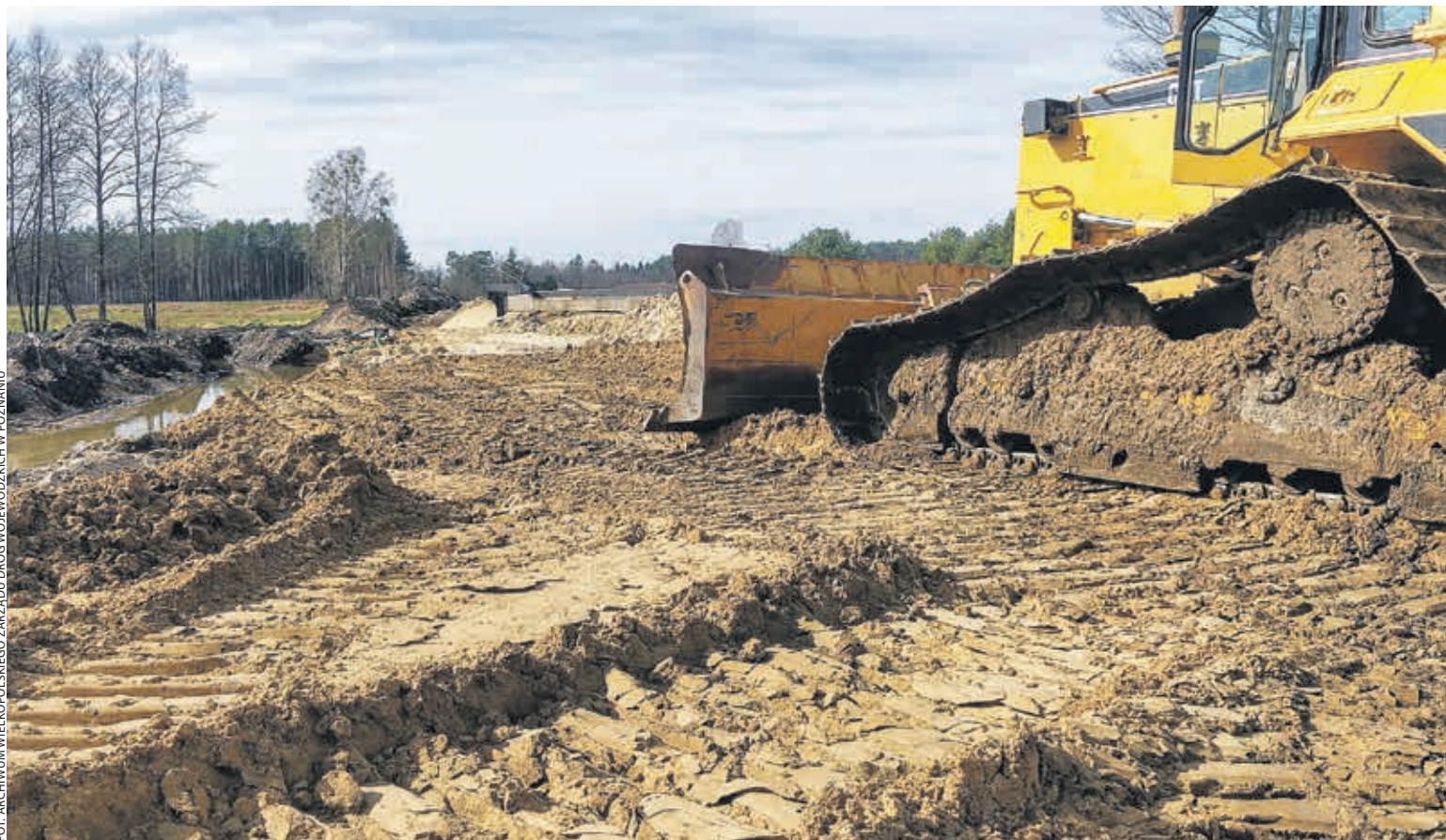
24 marca podpisano umowę na budowę obwodnicy Wronek. Drugi ważny kontrakt drogowy, na budowę nowego mostu w Rogalinie, czeka na rozstrzygnięcie.
