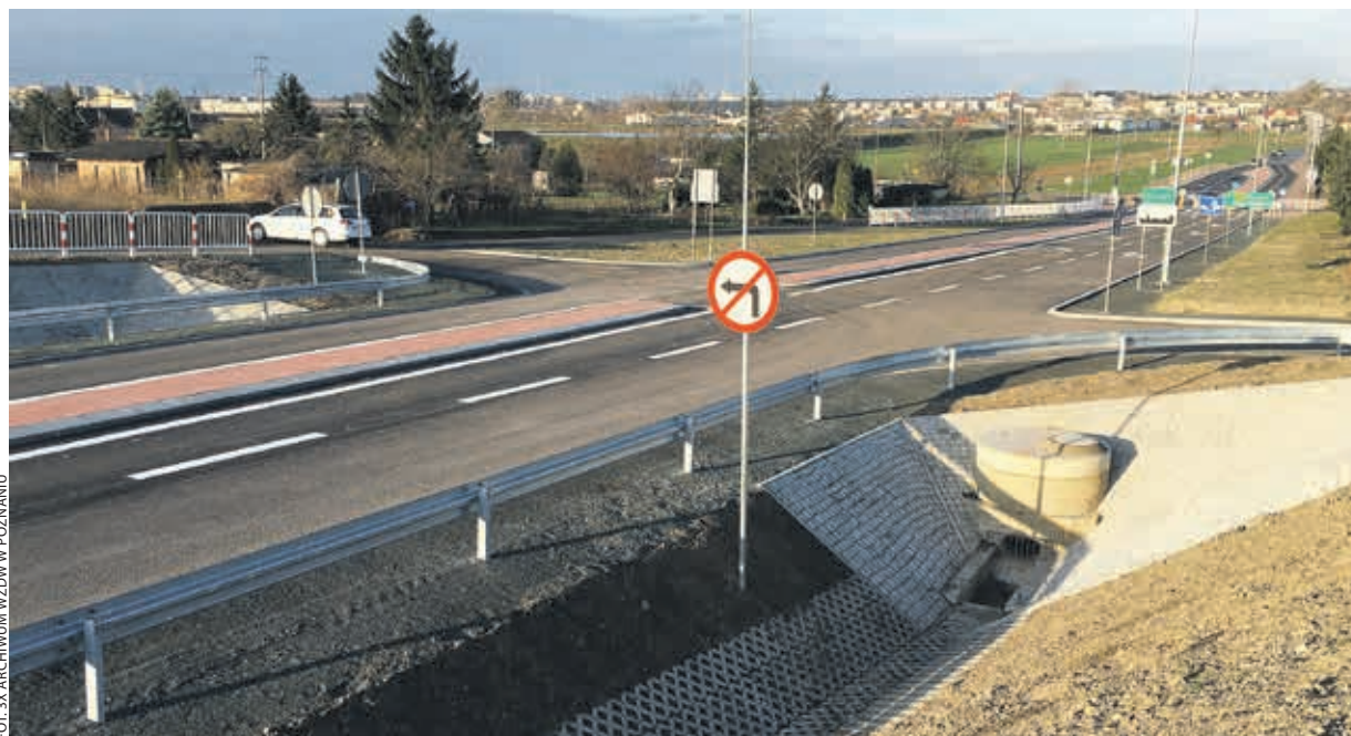
Budowa obwodnicy Gostynia ma kosztować łącznie 117 mln zł, w tym 85,2 mln zł to dotacja z WRPO 2014+.
