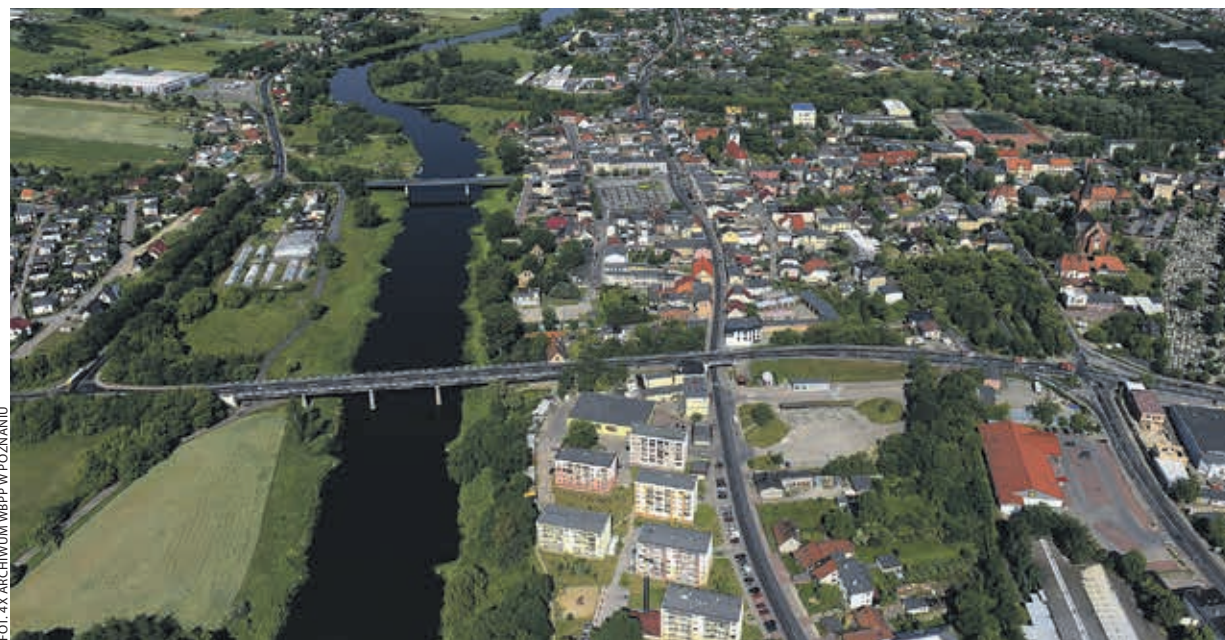
Budowa drogi ekspresowej S11, na którą czekają m.in. Oborniki (na zdjęciu), to jedna z najważniejszych inwestycji w Wielkopolsce.
