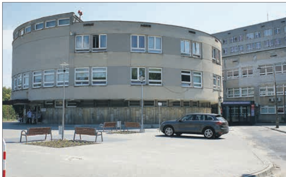
Szpital przy ul. Lutyckiej w Poznaniu jest w trakcie restrukturyzacji.
